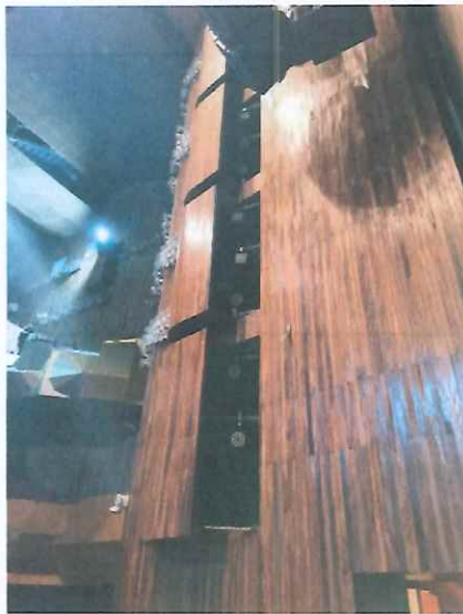
Colocación de reflectores en flautas
