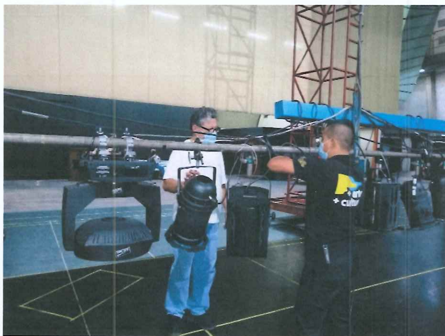
Montaje de equipos de luz en puente de iluminación.
