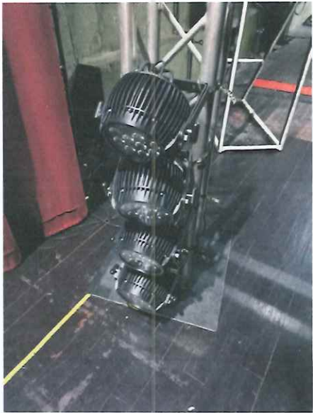
Colocación de rasantes laterales
