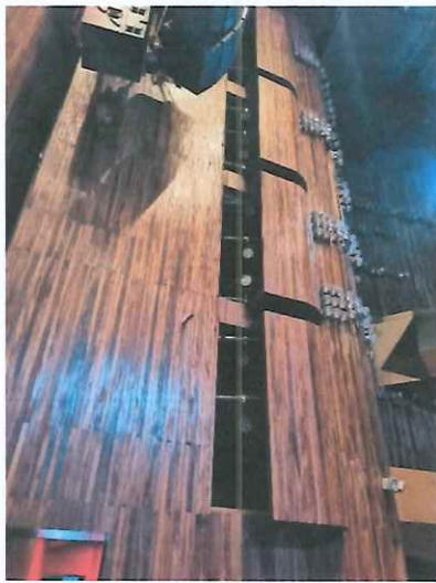
Colocación de reflectores en flautas.
